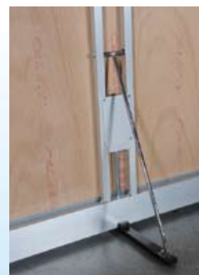
8. ステー（支柱）が固定された状態
