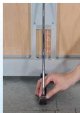
7. 脚穴に入れて、円形ねじを回して固定する
