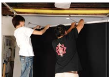
1. アームジョイントをボードに取り付ける
